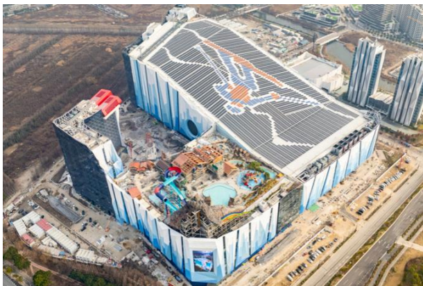
【建設中の耀雪アイスワールド】
