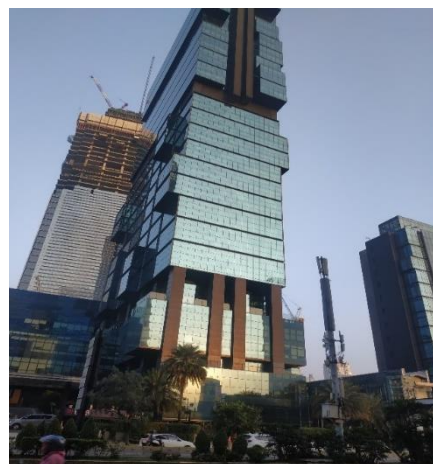
【ジャカルタの高層ビルとその背後に建設中のビル】
