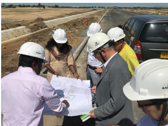
(建設が進む MIPC : マヒンドラ工業団地)
