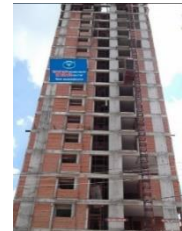
（ブロック積上で建設された高層ビル）
