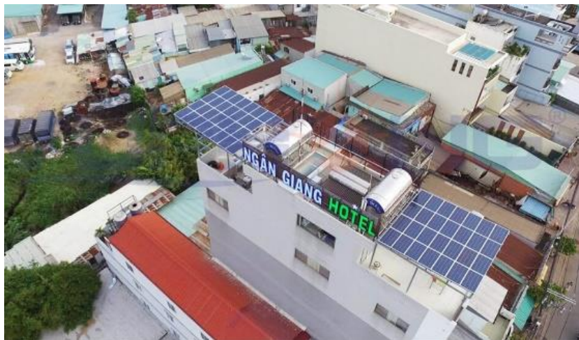
(屋上に設置した太陽光発電パネル 施工：Vu Phong 社)
