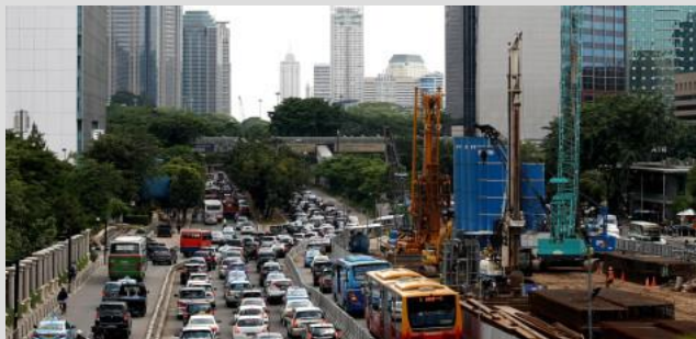
MRTの工事が進むジャカルタ市中心のスティルマン通り (Jakarta Globe より)
