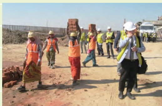
サナンド工業団地工場建設現場
